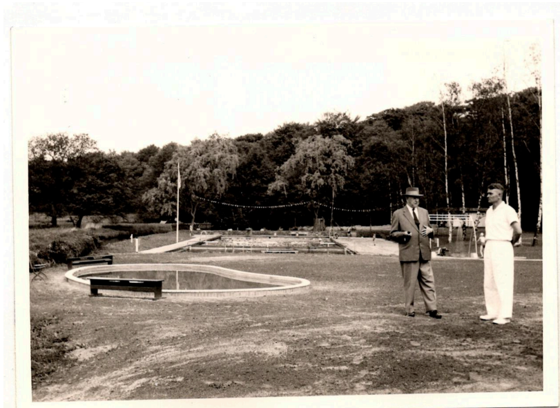
1959 nach der Übernahme und Renovierung durch die Stadt Syke
